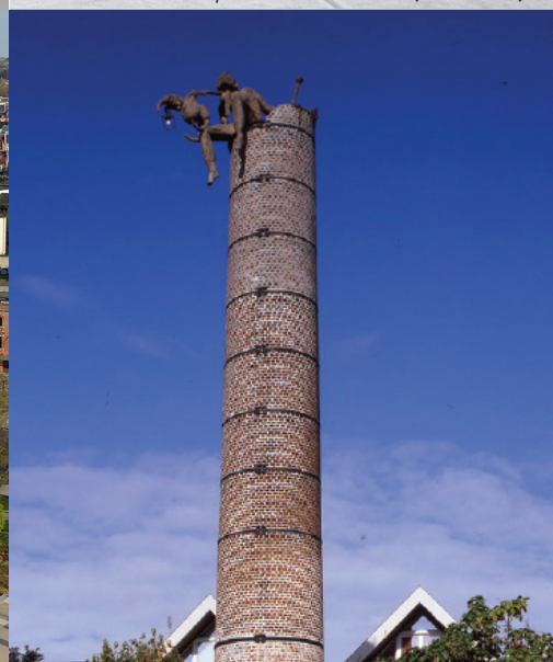
Cheminée de la brasserie du Nain d'Alsace - quartier Remicourt
